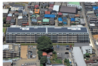
レーベンハイム光が丘公園(株)タカラレーベンに設置されたマンション用別太陽光発電システム
