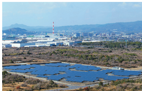
下松メガソーラー発電所
